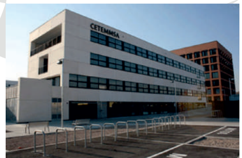
Revisió periòdica d'instal·lacions del centre CETEMMSA de Mataró
