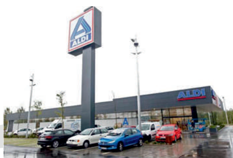
Instal·lacions del nou Aldi de l'Avinguda Josep Tarradellas, 13 de Girona
