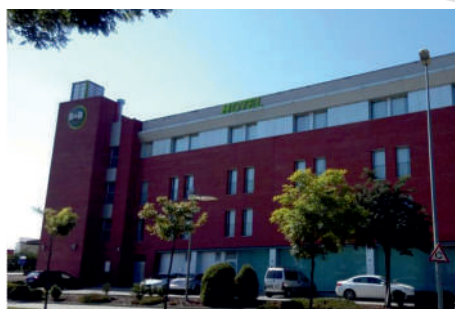
Manteniment d'instal·lacions de l'Hotel B&B de Salt
