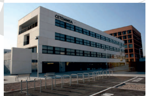
Revisió periòdica d'instal·lacions del centre CETEMMSA de Mataró
