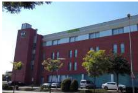
Manteniment d'instal·lacions de l'Hotel B&B de Salt
